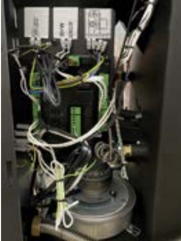
Hauptplatine mit Anschluss des Pufferfühlers (BHW Sensor)
