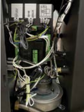
Hauptplatine mit Anschluss des Pufferfühlers (BWH Sensor)
