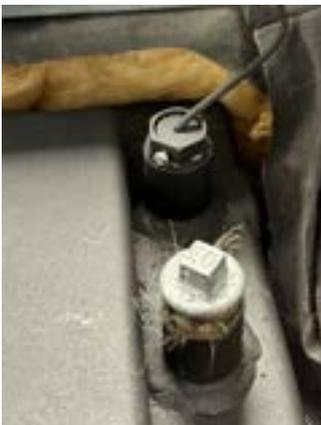
Kesselfühler zur genauen Kontrolle der Wassertemperatur, der Kesselleistung und der Pyrolyse.
