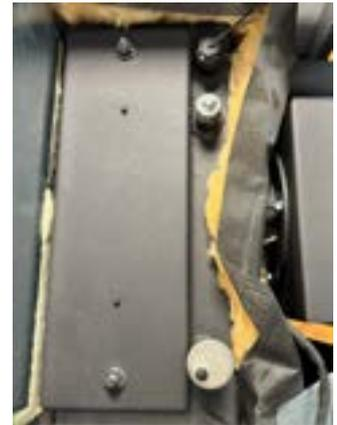
Deckplatte des Wärmetauschers mit Zugang zu den Turbulatoren und dem Reinigungsmechanismus.
