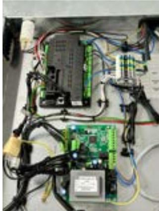
Unter der oberen Verkleidung des Pyromax Pro sind die Steuerplatine, Lambda-Regelung und alle Elektroanschlüsse sicher untergebracht.
